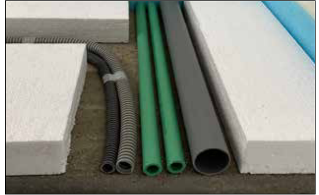
Installationsebene mit Dämmplatten des Anwendungstyps DE0 auslegen
