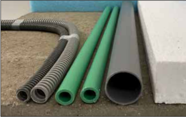
Installationen auf der Rohdecke
